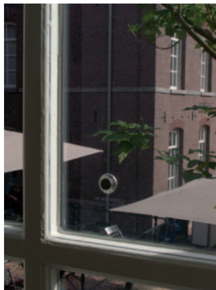
▲ In de Hermitage in Amsterdam is reeds in 2009 Pilkington Spacia toegepast; de beschermcaps in de ruiten zijn regelmatig verdeeld. Foto's: Pilkington
