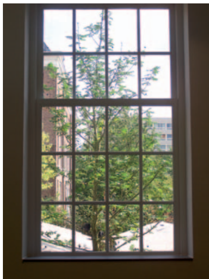
▲ In de Hermitage in Amsterdam is reeds in 2009 Pilkington Spacia toegepast; de beschermcaps in de ruiten zijn regelmatig verdeeld. Foto's: Pilkington
