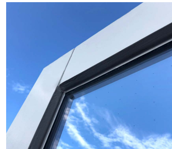
Dankzij het dunne FINEO vacuümglas kon de enkele en dubbele beglazing vervangen worden met behoud van de bestaande kozijnen.
