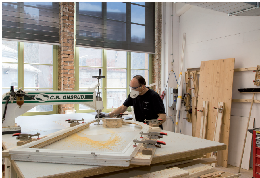
Die bestehenden Profile müssen für die folgende Behandlung mit zumeist Leinölfarben vorbereitet werden.
