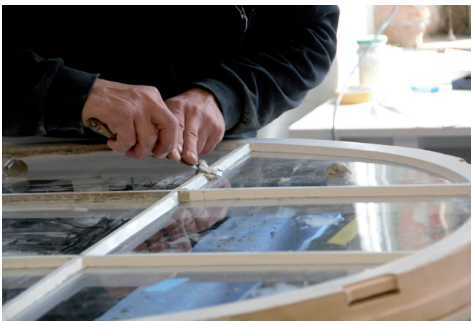
Zunächst wird der „Fensterkitt“ aus den historischen Elementen händisch entfernt.
