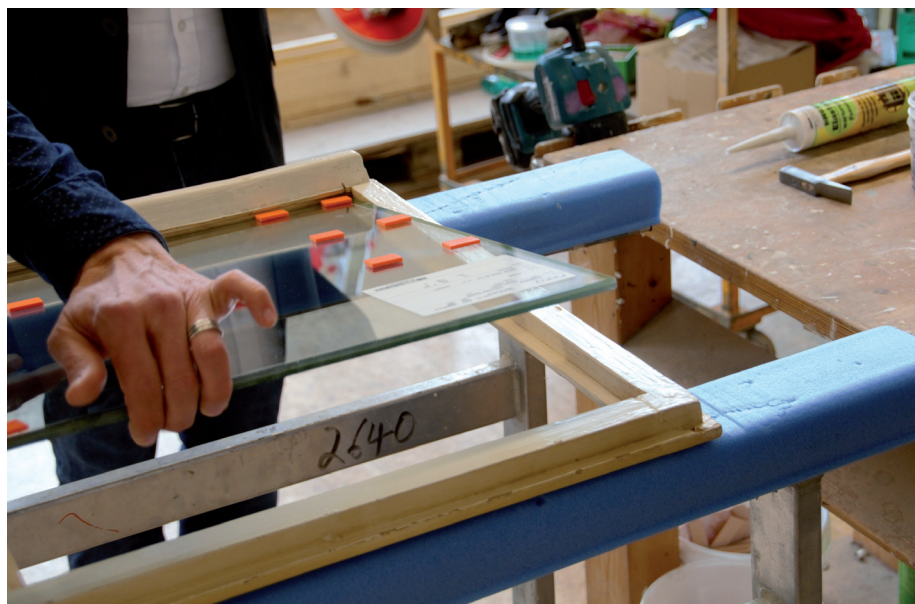
Schlussendlich wird das Vakuumglas in den vorbereiteten Rahmen eingesetzt. Jede Scheibe wird von Hand verglast.
